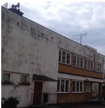
Fot. 5. Fragment elewacji północnej bud. „C” z widocznymi kratkami wentylacyjnymi.
