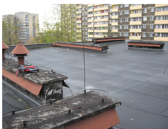
Fot. 9. Dach segmentu „A” („C”) z widocznymi osłonami przewodów wentylacyjnych.
